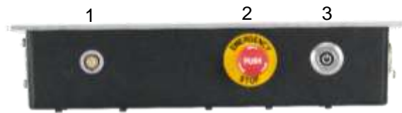
FIGURA 2 - Vista frontal de la caja de controles
