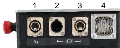
BILD 3 – Högersidan Av Kontrollenheten
